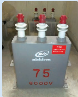
電力用コンデンサー
