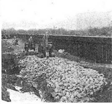
災害復旧工事の増加が人手不足に拍車をかけた(長野市の堤防復旧工事)
