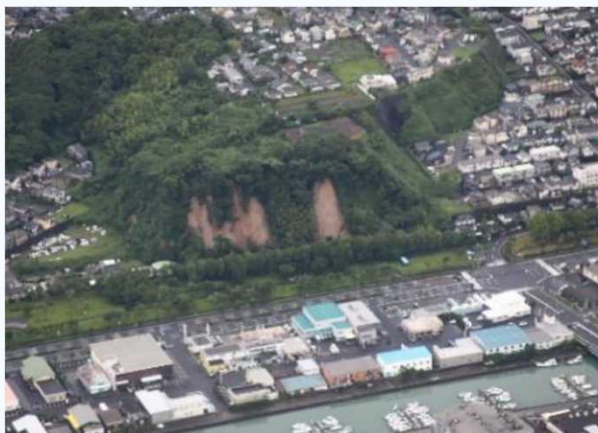
土砂災害の状況（鹿児島市）
