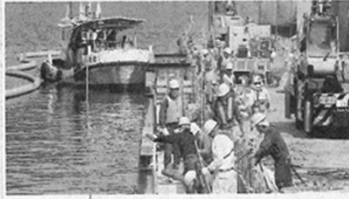
農災で被害を受けた気仙沼港の岸壁復旧工事(宮城県気仙沼市)
