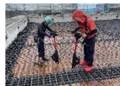
鉄筋結束ロボット
