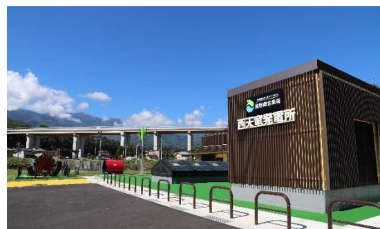
西天竜発電所・西天でんでん広場
