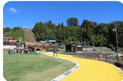
西天竜発電所・西天でんでん広場
